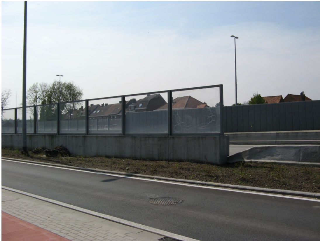
Voorbeeld van een doorzichtig geluidsscherm, zoals geplaatst bij Velodroomstraat, aan de oostzijde (dus aan onze kant)
